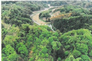
トンネル上空(ドローン映像)
